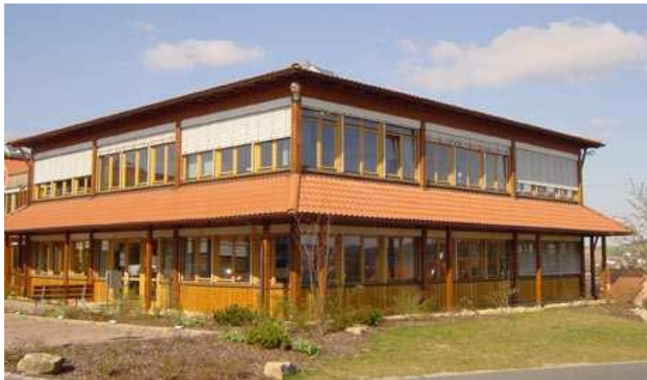
Abbildung 1: Pavillonansicht Technologiepark Würzburg-Rimpar 4
